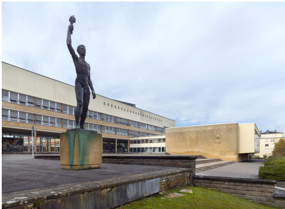
L'Athénée de Luxembourg avant les travaux de rénovation
