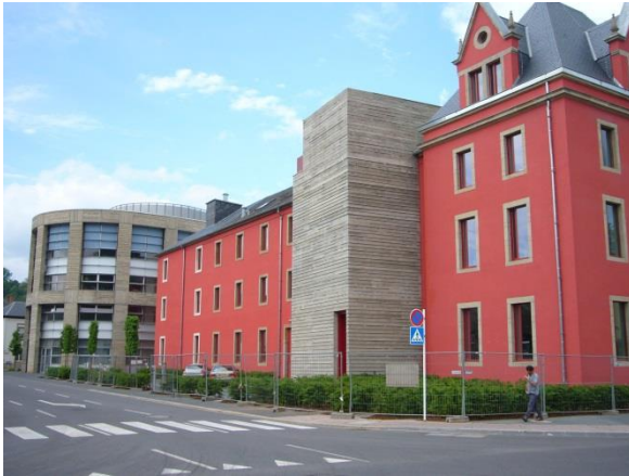
Lycée classique de Diekirch - achevé
