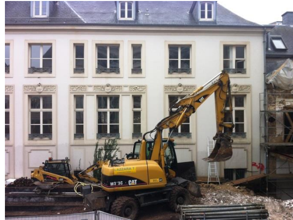
Cour des comptes à Luxembourg – en exécution
