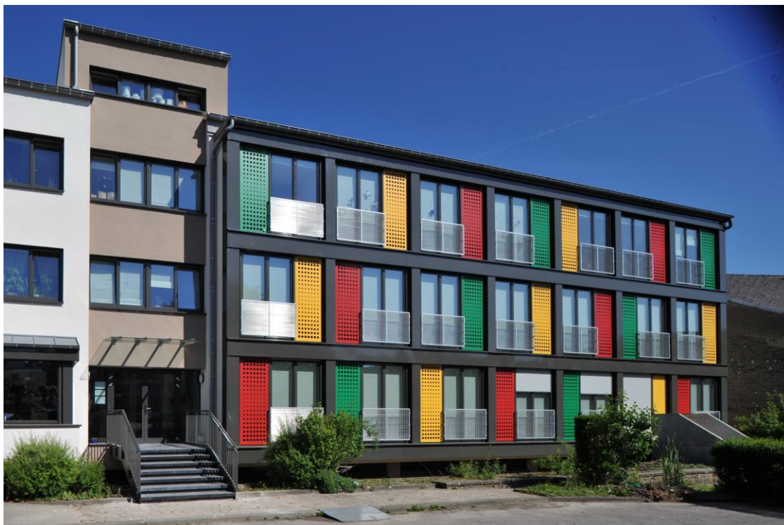
Le « Kannerhaus » à Junglinster après les travaux de rénovation.
