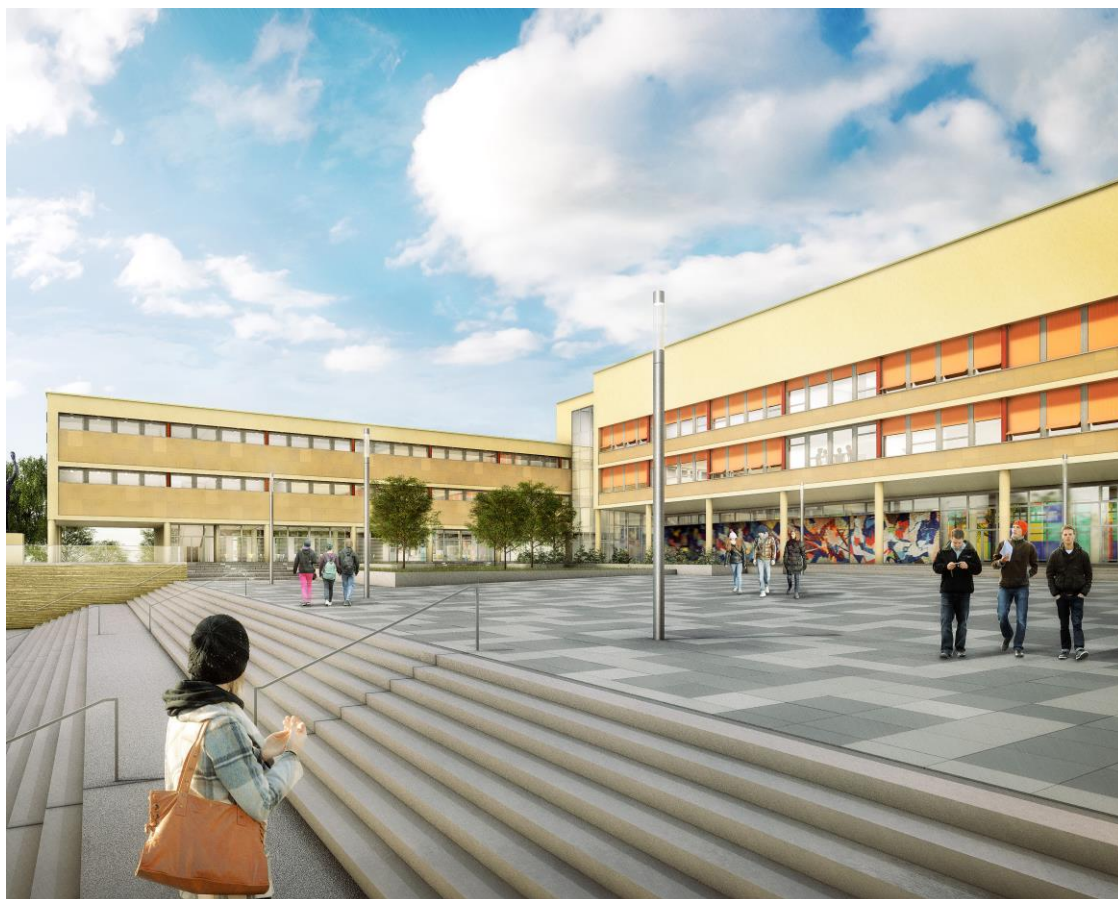
Illustration de l'Athénée de Luxembourg après achèvement des travaux de rénovation
