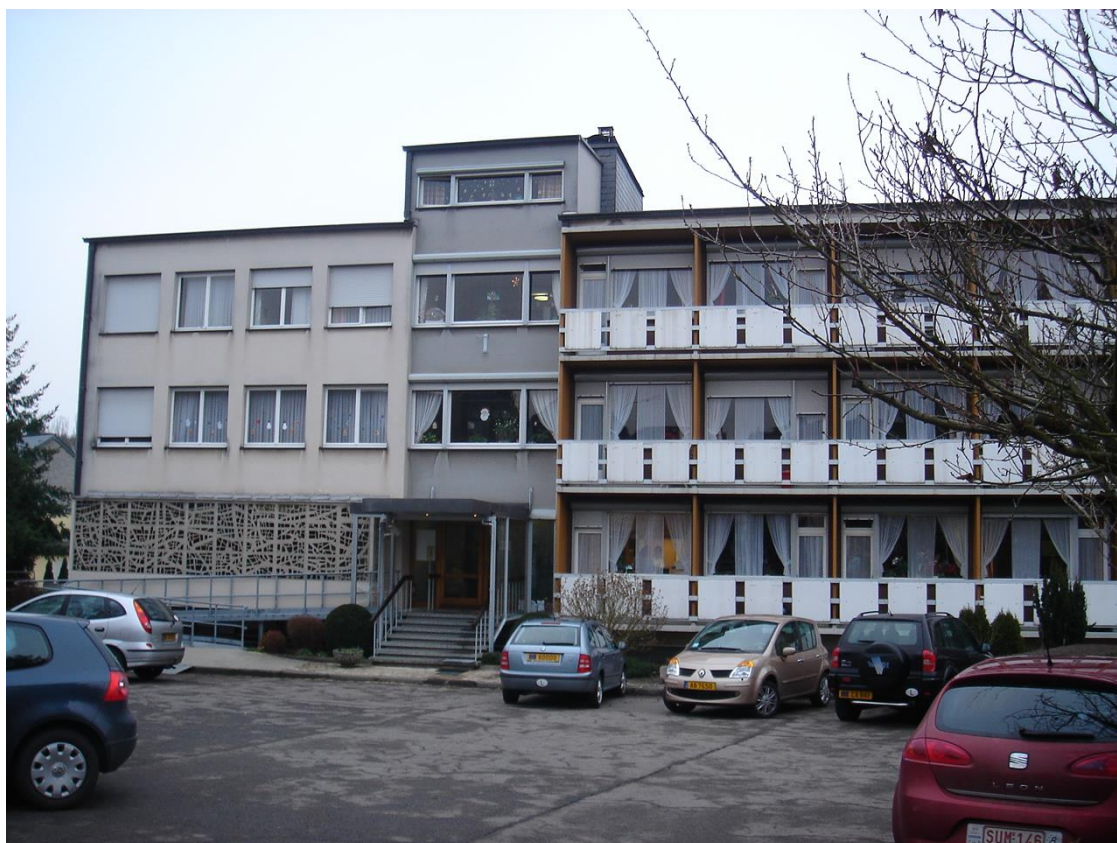
Le « Kannerhaus » à Junglinster avant les travaux de rénovation
