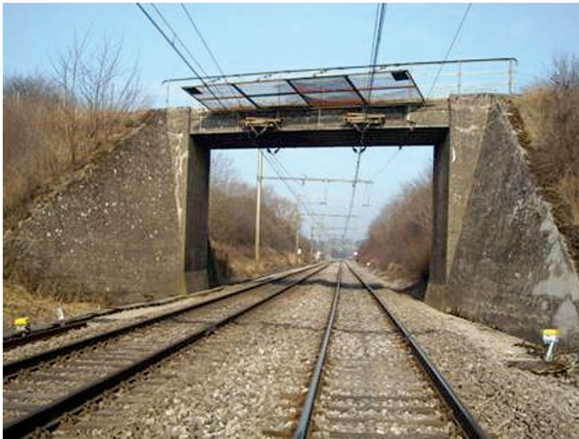
ouvrage d'art situé au point kilométrique 8,913 à Mamer-Lycée
