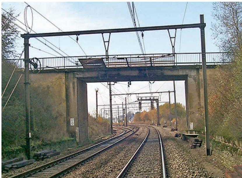
ouvrage d'art situé au point kilométrique 17,030 à Kleinbettingen
