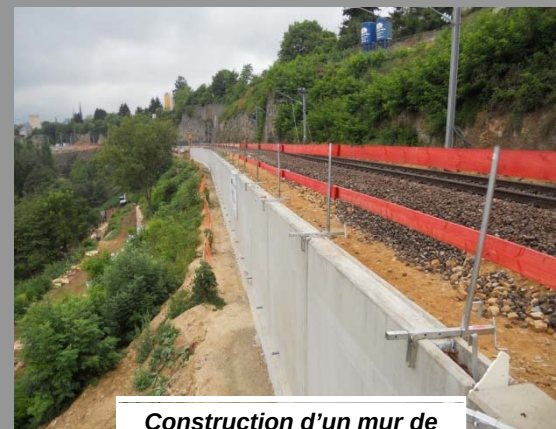
Construction d'un mur de soutènement
