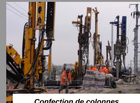
Confection de colonnes ballastées
