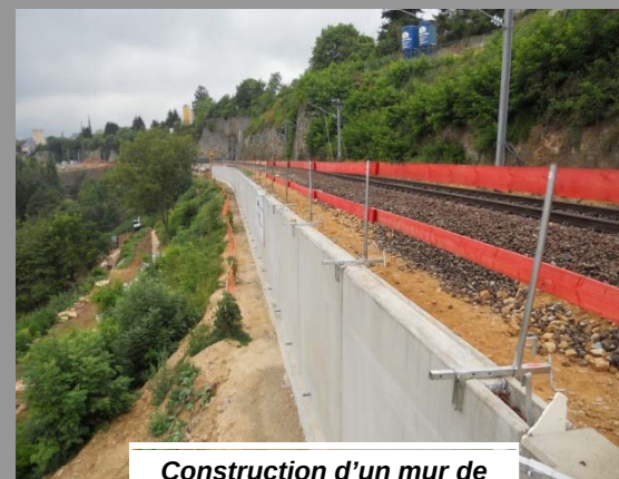
Construction d'un mur de soutènement
