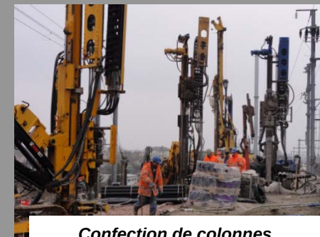
Confection de colonnes ballastées
