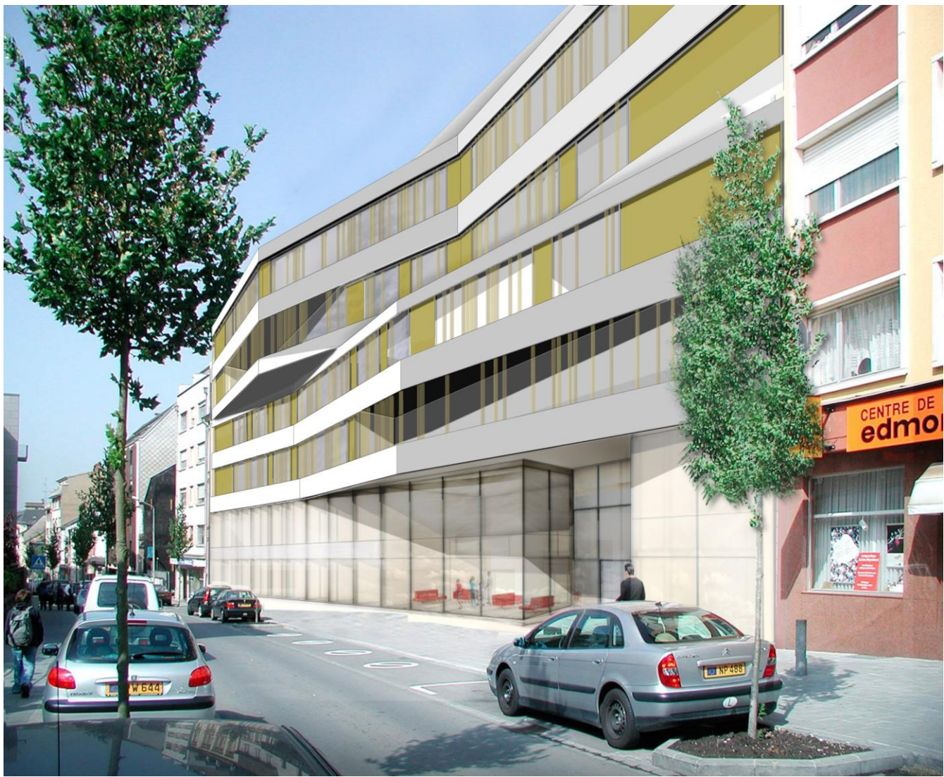
Nouvelle construction (rue d'Anvers)
