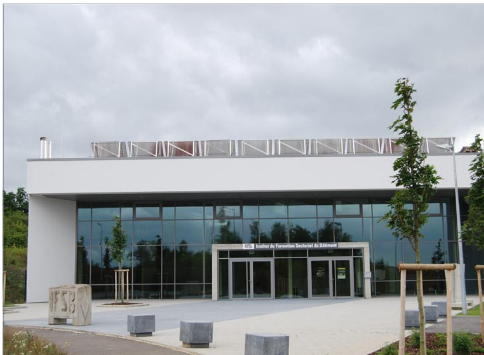
L'entrée du Building Training Center IFSB
