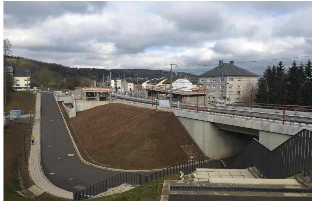
Arrêt Oberkorn avec passage inférieur reliant la rue Prince Henri et la rue des Mines
