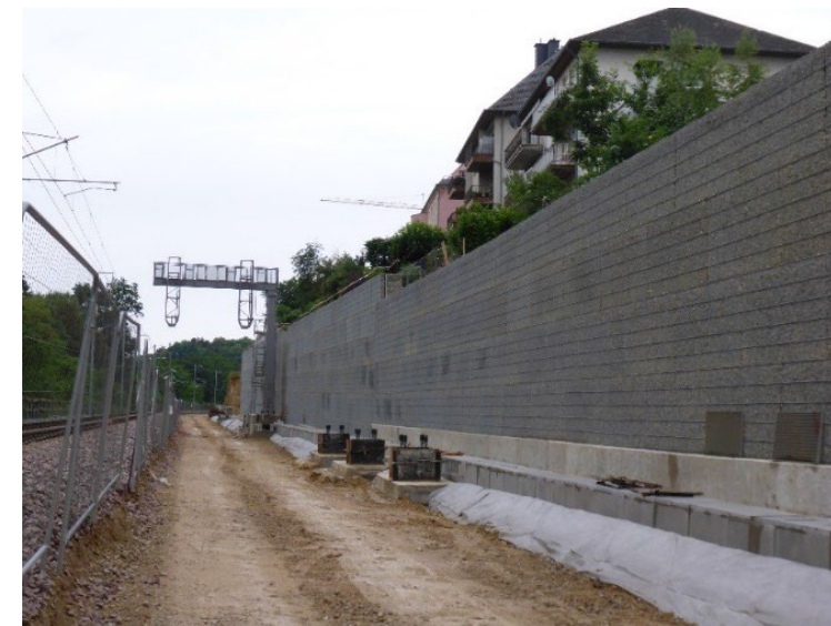
Mur de protection acoustique quartier de Cents
