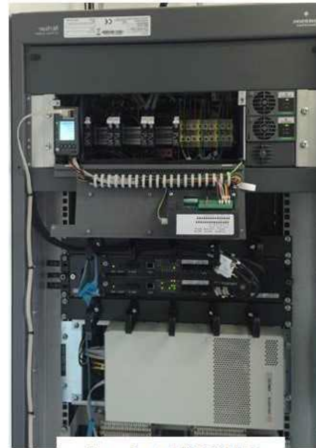
Armoire BTS GSM-R
