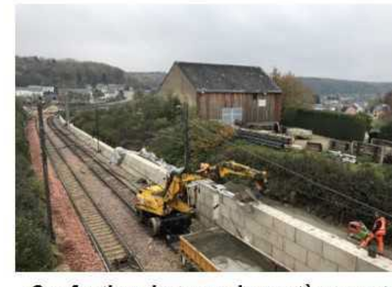
Confection de murs de soutènement
