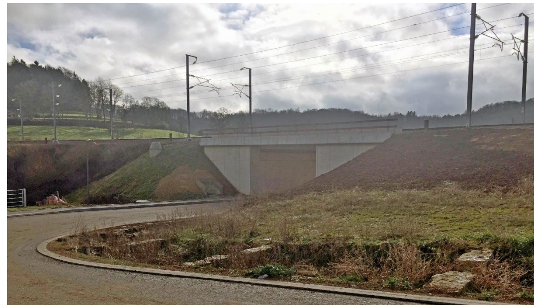
Passage inférieur reliant la rue de la Gare et la rue Dalscheidt
