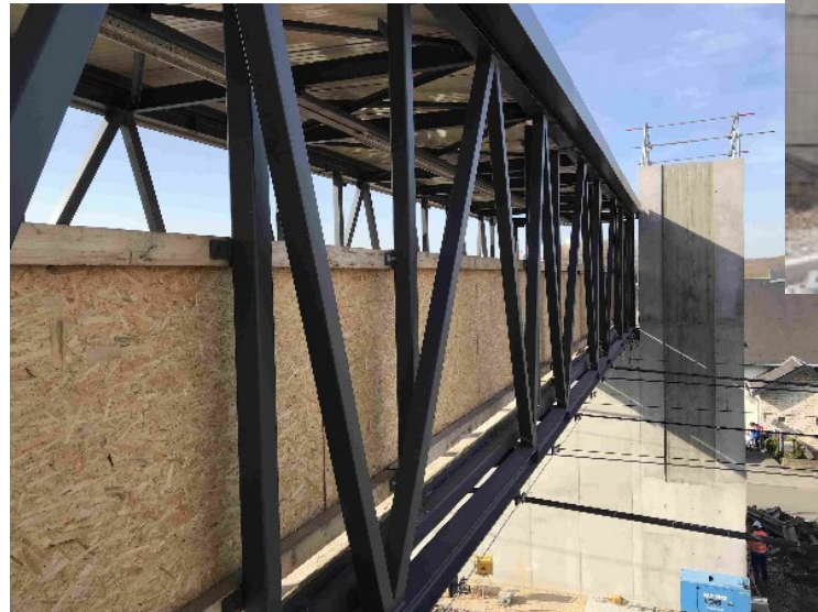
Construction de la future passerelle piétonne au droit de l'ancien PN92
