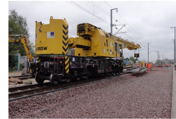
Nouvelle plate-forme deuxième voie / Pose panneaux de voie / mise en service double voie
