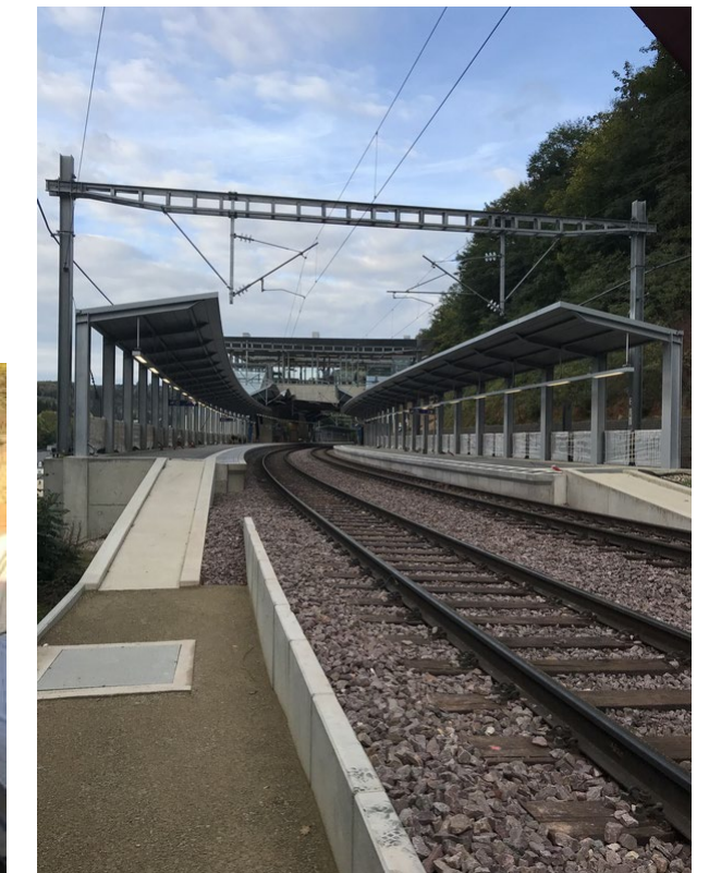
Nouvel arrêt ferroviaire
