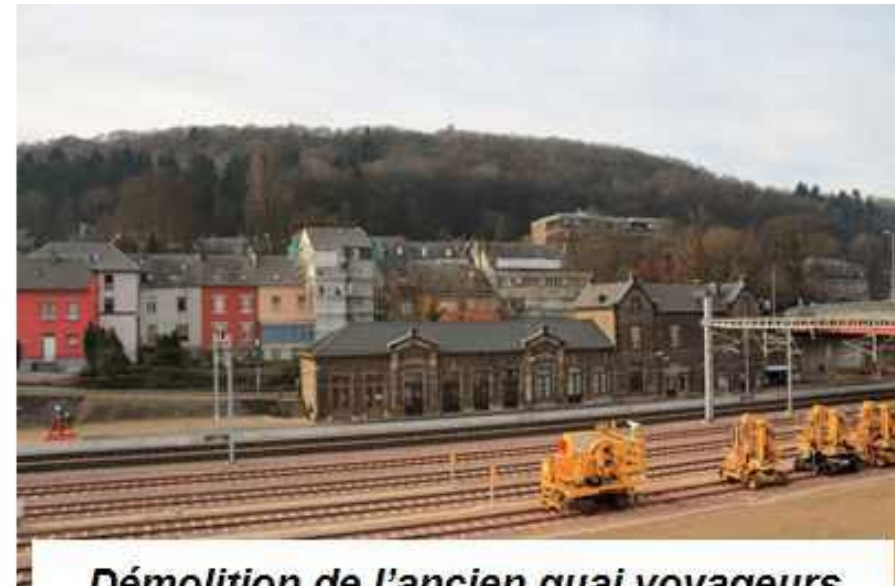
Démolition de l'ancien quai voyageurs
