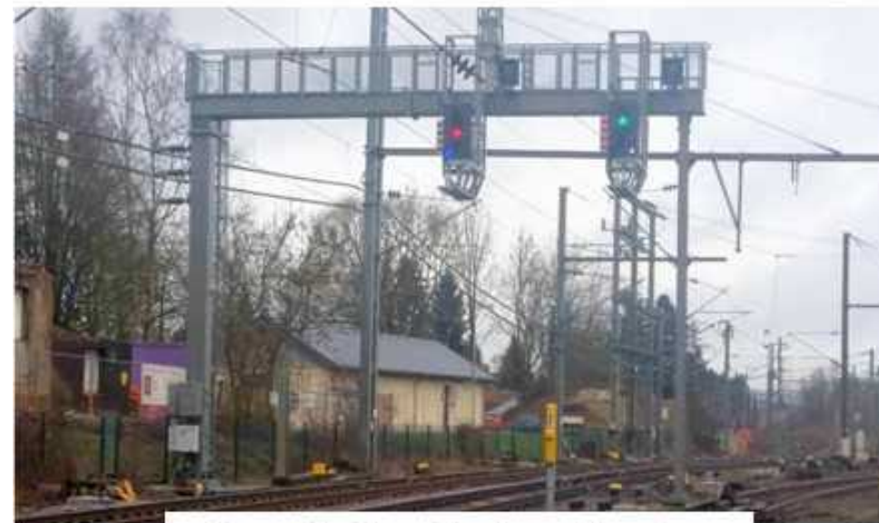
Installation de signalisation
