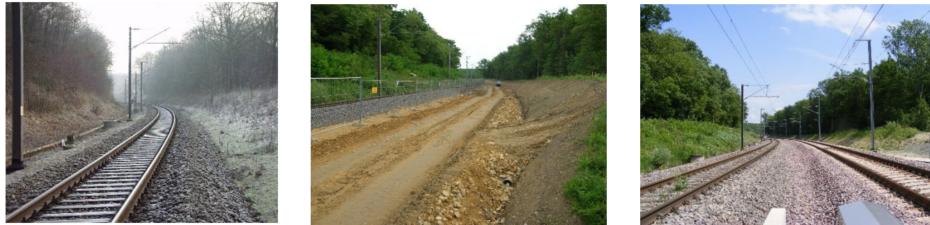
Mise à double voie entre Pétange et Bascharage-Sanem Situation avant, pendant et après travaux
