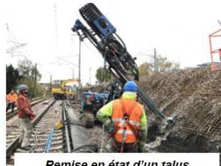
Remise en état d'un talus ferroviaire par une paroi cloutée
