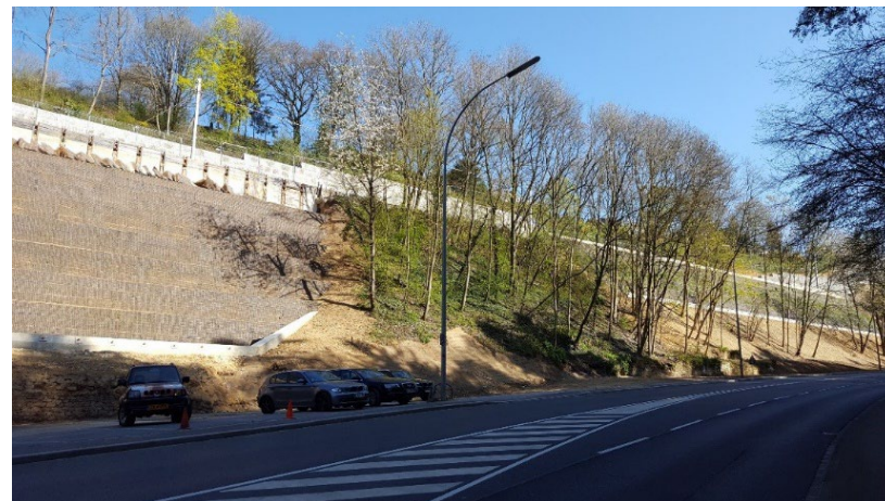
Reconstruction des perrés Val de Hamm
