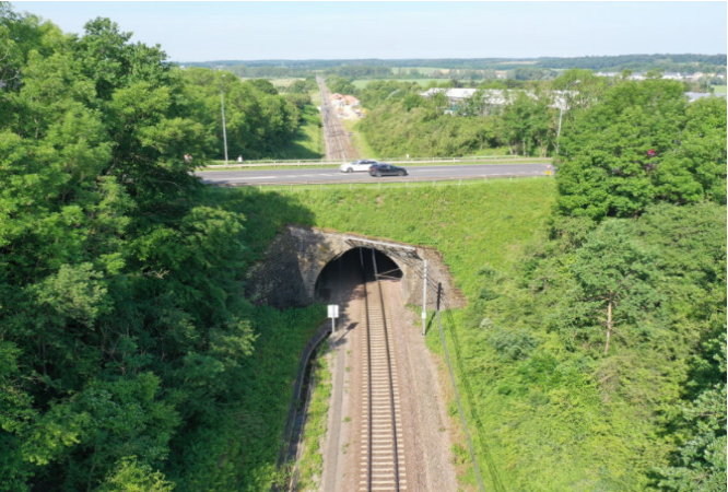
Démolition et reconstruction de l'ouvrage d'art OA756 existant. Elargissement des gabarits ferroviaires et routiers.
