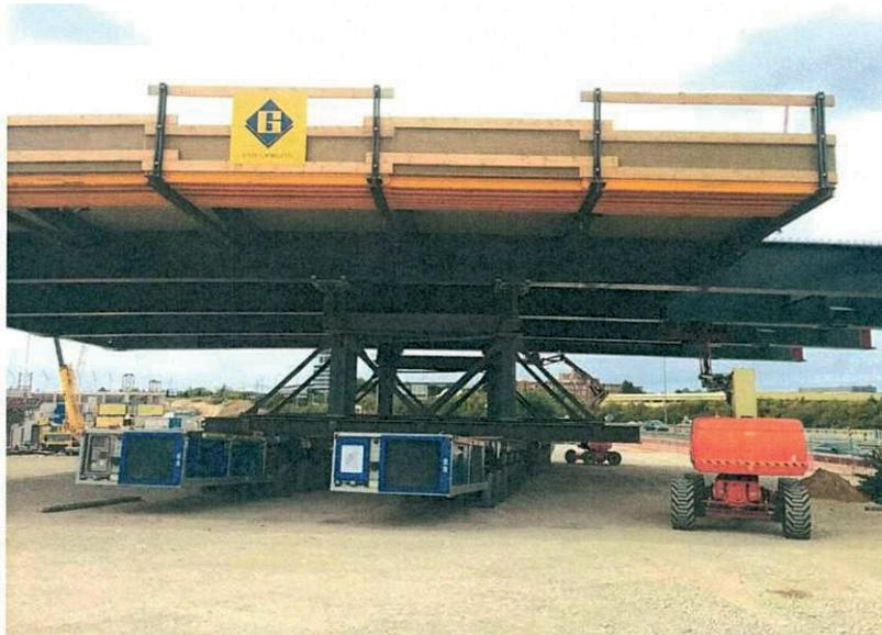
*Figure 28 Ouvrage d'art OA17 – Déviation de l'autoroute A6 pendant les travaux de mise en place de l'ouvrage*
