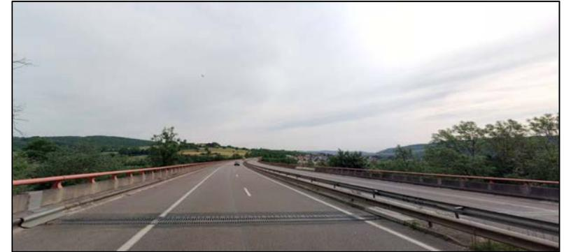
La longueur totale de l'ouvrage est de 375 mètres suivant une subdivision en 11 travées d'environ 34 mètres chacune. La surface générale de l'ouvrage est d'environ 8.900 m<sup>2</sup>
