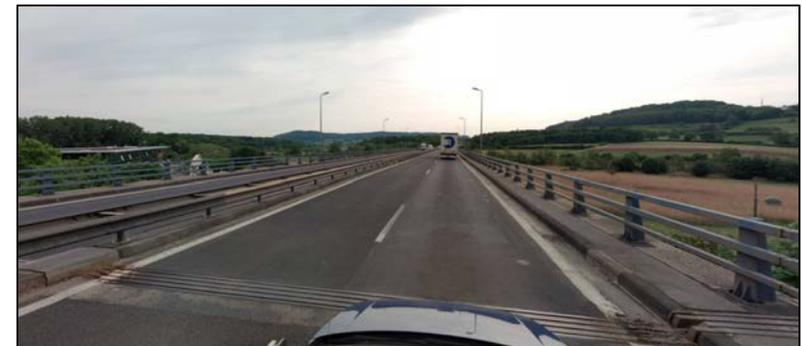
Le projet relatif au présent ouvrage prévoit, outre une réhabilitation complète et une mise à niveau de sa superstructure et de ses équipements, une réhabilitation partielle des piles et des culées, ainsi qu'un renforcement structurel afin de pouvoir répondre au besoin d'une infrastructure routière moderne et en concordance avec les normes actuelles en vigueur.
