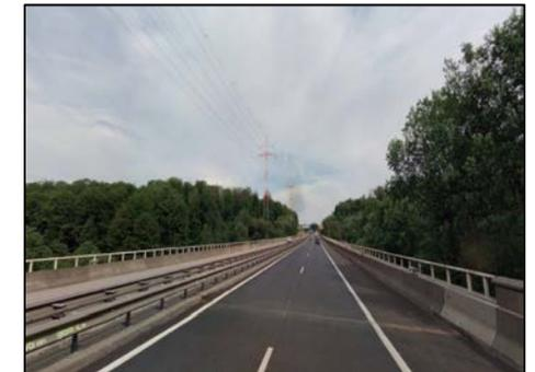
Le projet relatif au présent ouvrage prévoit, outre une réhabilitation complète et une mise à niveau de sa superstructure et de ses équipements, une réhabilitation partielle des piles et des culées, ainsi qu'un renforcement structurel afin de pouvoir répondre au besoin d'une infrastructure routière moderne et en concordance avec les normes actuelles en vigueur.
