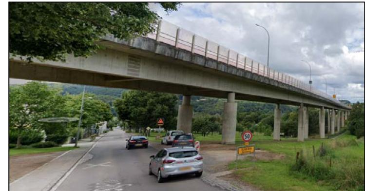
Le projet relatif au présent ouvrage prévoit, outre une réhabilitation complète et une mise à niveau de sa superstructure et de ses équipements, une réhabilitation partielle des piles et des culées, ainsi qu'un renforcement structurel afin de pouvoir répondre au besoin d'une infrastructure routière moderne et en concordance avec les normes actuelles en vigueur.
