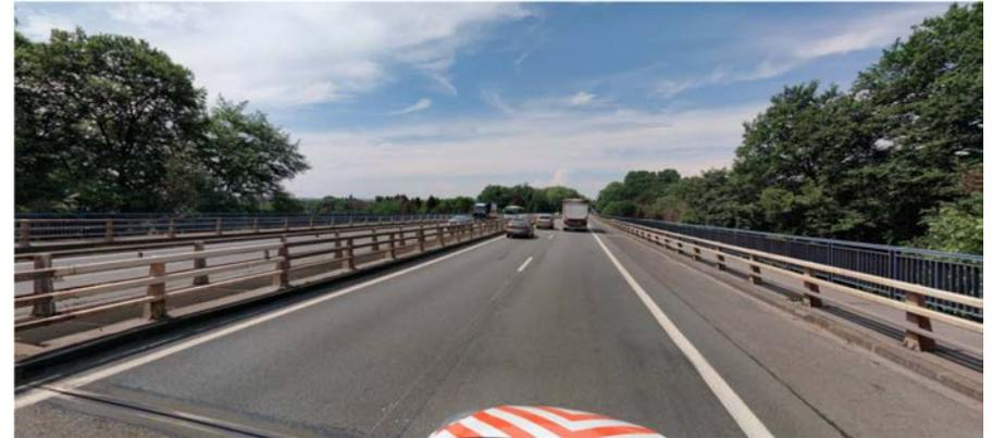
La longueur totale de l'ouvrage est de 252 mètres suivant une subdivision en 8 travées de 31.3 mètres chacune. La surface générale de l'ouvrage est d'environ 6.800 m<sup>2</sup>.
