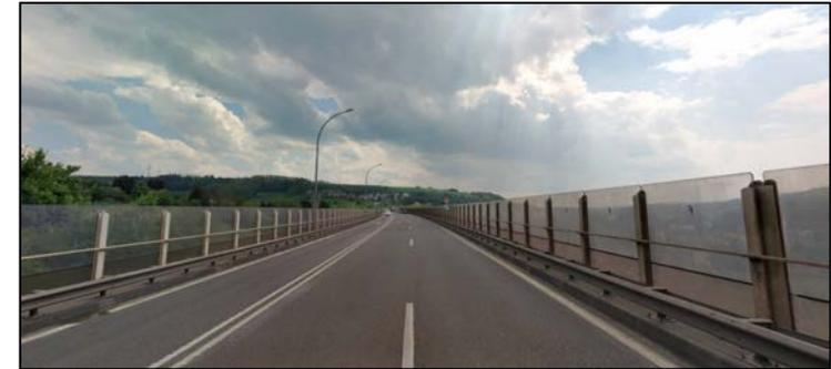
La longueur totale de l'ouvrage est de 396 mètres suivant une subdivision en 11 travées. La surface générale de l'ouvrage est d'environ 5.000 m<sup>2</sup>
