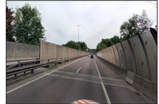
La longueur totale de l'ouvrage est de 258 mètres et il est subdivisé en 6 travées, quatre travées de 48 mètres et deux travées de 30 mètres. La surface générale de l'ouvrage est d'environ 7.500 m<sup>2</sup>.
