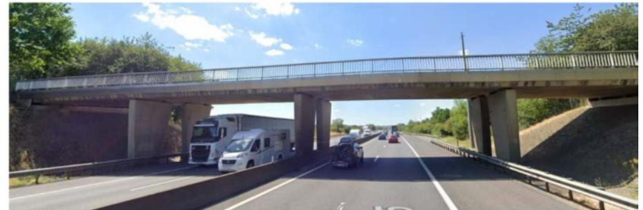
La longueur totale de l'ouvrage est de 52 mètres suivant une subdivision en 4 travées, dont deux de 14 mètres et deux de 9.6 mètres. La surface générale de l'ouvrage est d'environ 500 m<sup>2</sup>.
