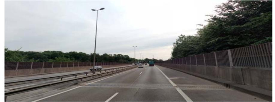
La longueur totale de l'ouvrage est de 224 mètres suivant une subdivision en 5 travées, dont trois travées de 48 mètres et deux travées de 40 mètres. La surface générale de l'ouvrage est d'environ 5.500 m<sup>2</sup>
