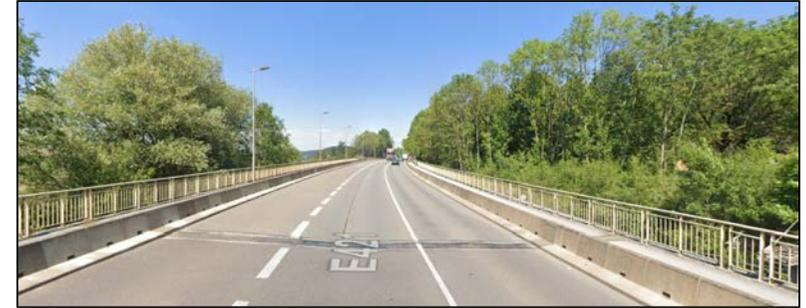
La longueur totale de l'ouvrage est de 70 mètres suivant une subdivision en 2 travées d'environ 34 mètres chacune. La surface générale de l'ouvrage est d'environ 1.200 m<sup>2</sup>.
