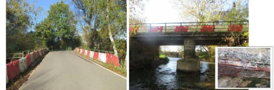
Lors des inspections visuelles, l'ouvrage OA1266 fût classé B, c'est-à-dire : ouvrage ou partie d'ouvrage qui présente des défauts indiquant que l'évolution de détérioration risque de se faire anormalement. En outre la largeur utile (entre les garde-corps) est de 6.84 m avec une largeur roulable de 4.8 m (normalement 6 m pour un CR). Les garde-corps sont donc beaucoup trop près du bord de chaussée !
