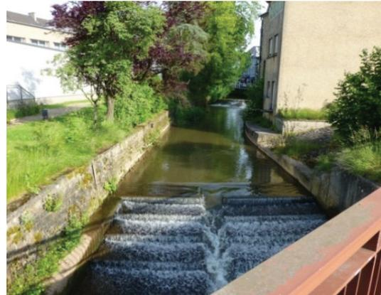
Le perré existant sera en partie conservé le long des murs pour éviter des reprises en sous-œuvre et pour limiter l'impact sur le niveau de crue suite à l'augmentation de la rugosité du fond du ruisseau.
