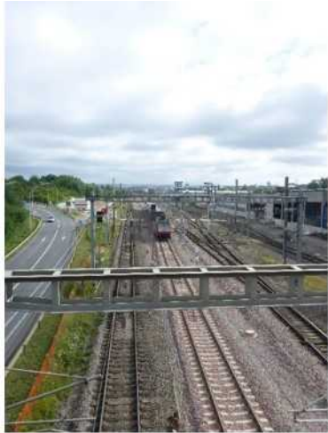
Mise en service de la voie 622
