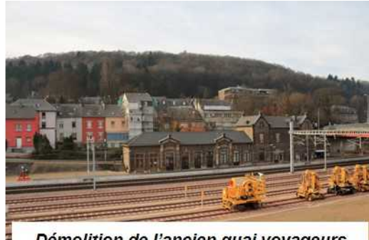
Démolition de l'ancien quai voyageurs
