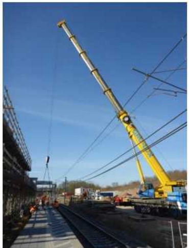
Pose de l'escalier
