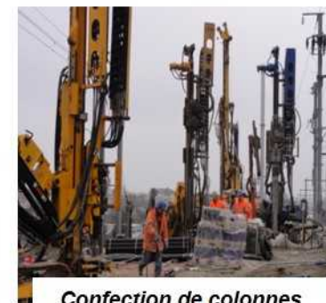
Confection de colonnes ballastées
