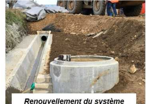
Renouvellement du système d'évacuation d'eaux pluviales
