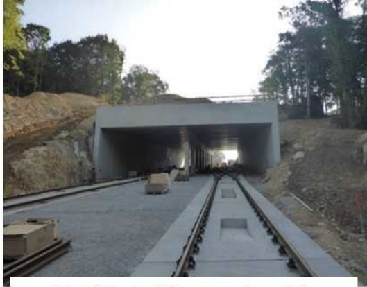
Tracé funiculaires avec tranchée couverte
