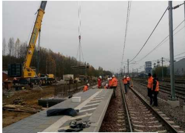
Mise en œuvre des fondations
