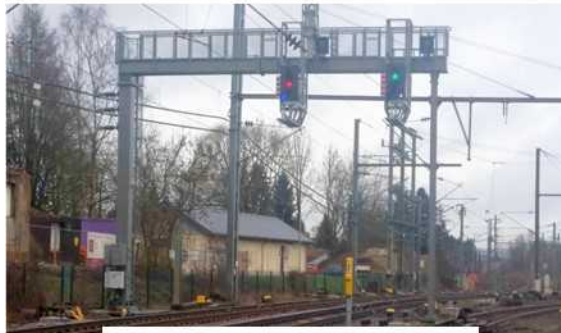
Installation de signalisation
