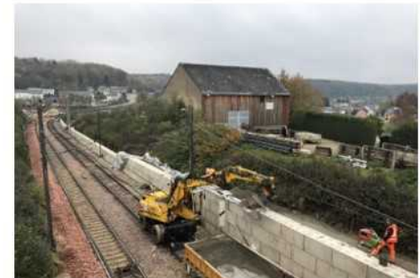
Confection de murs de soutènement
