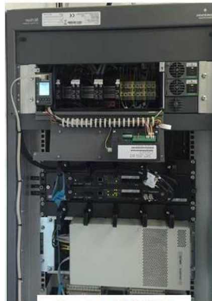
Armoire BTS GSM-R
