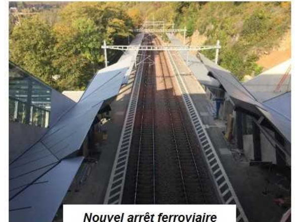
Nouvel arrêt ferroviaire
