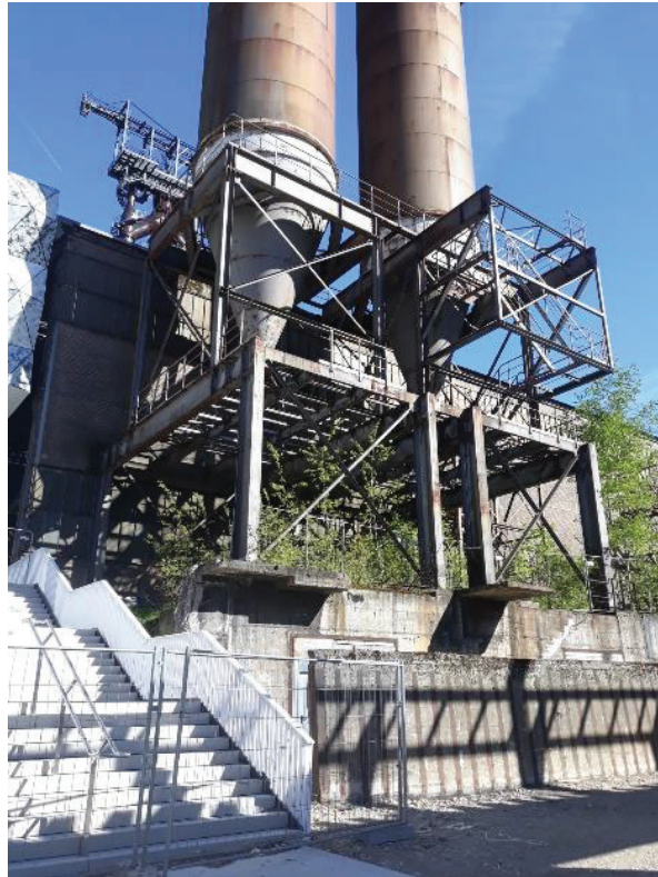
Möllerei, vue ouest
