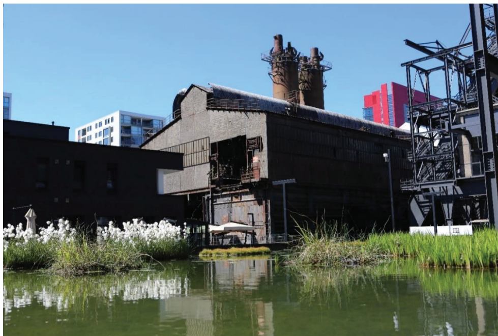
Möllerei, vue sud-est
