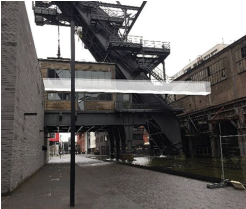
Möllerei, vue nord-est sur la nouvelle passerelle
