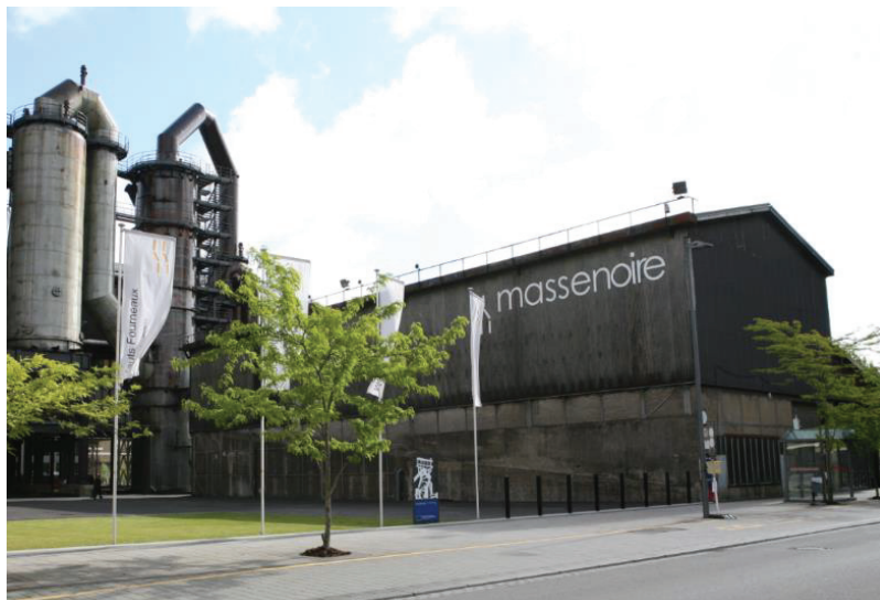
Massenoire, vue sud-ouest
