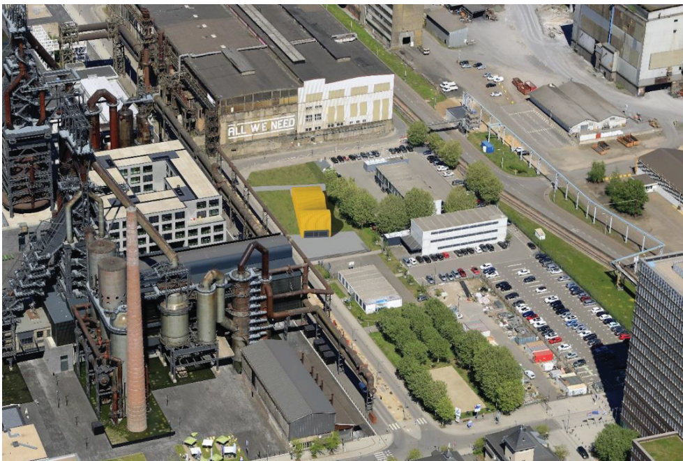
Skip, vue aérienne
