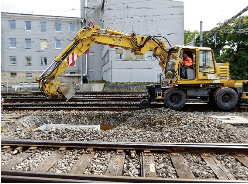
Travaux génie civil
