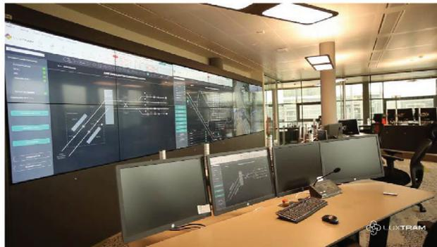
Le PCC gère la régularité de la fréquence du tramway. En cas de perturbation, il est en interface avec l'ensemble des conducteurs pour limiter les retards et désagréments.
