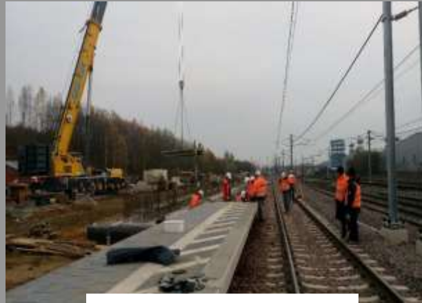
Mise en œuvre des fondations
