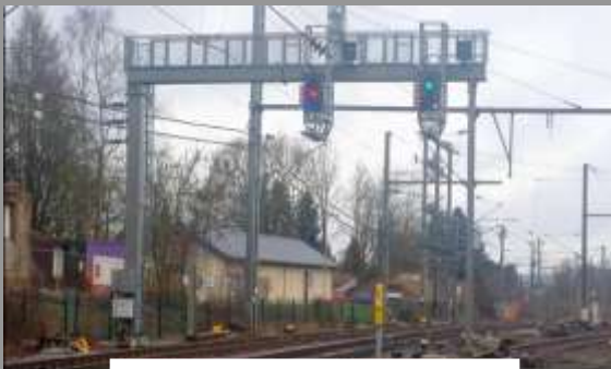
Installation de signalisation
