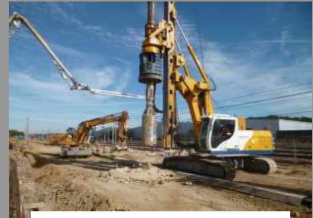
Pose des éléments de quais préfabriqués
