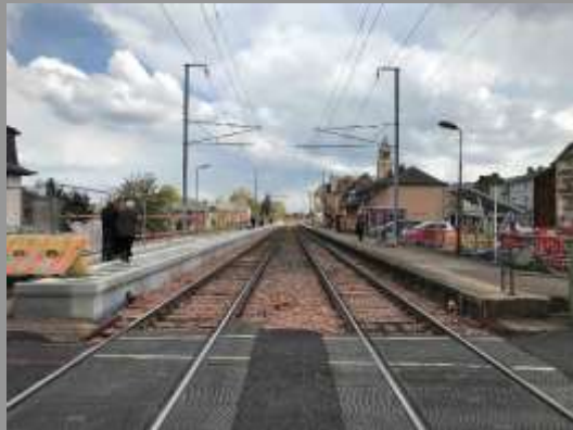
Reconstruction quai voie 1
