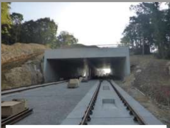
Tracé funiculaires avec tranchée couverte
