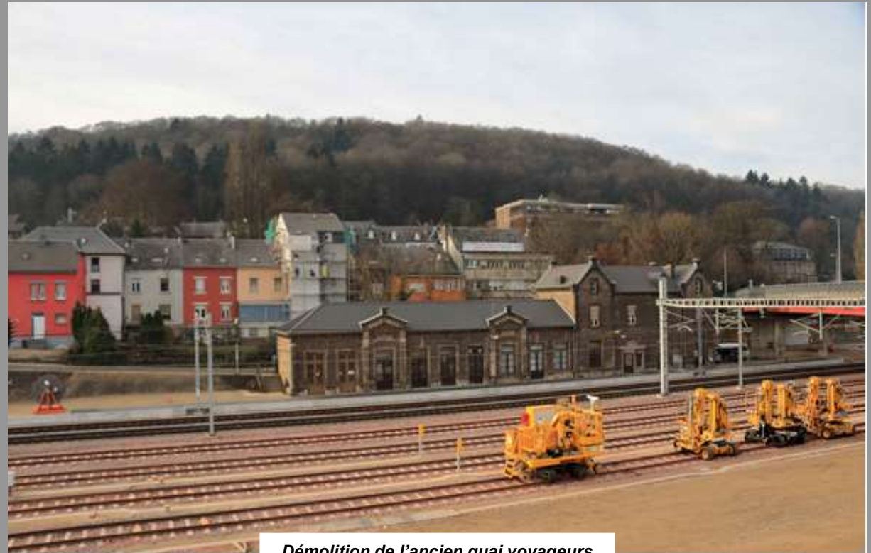
Démolition de l'ancien quai voyageurs
