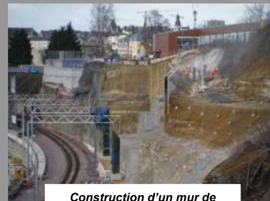
Construction d'un mur de soutènement
