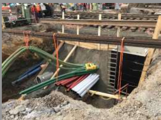
Déviations réseaux tiers
