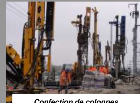
Confection de colonnes ballastées
