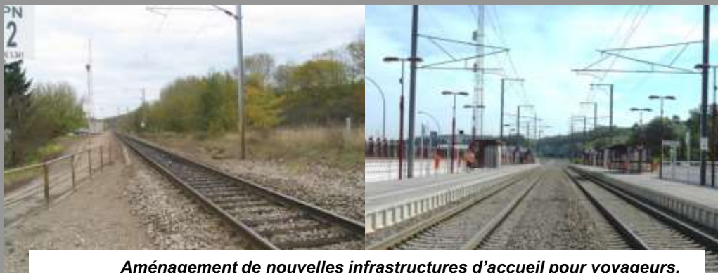
Aménagement de nouvelles infrastructures d'accueil pour voyageurs. Arrêt Bascharage-Sanem avant et après travaux.
