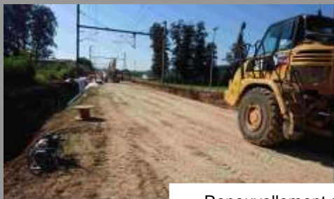
Renouvellement complet des voies avec amélioration des plate-formes entre Colmar-Berg et Schieren
