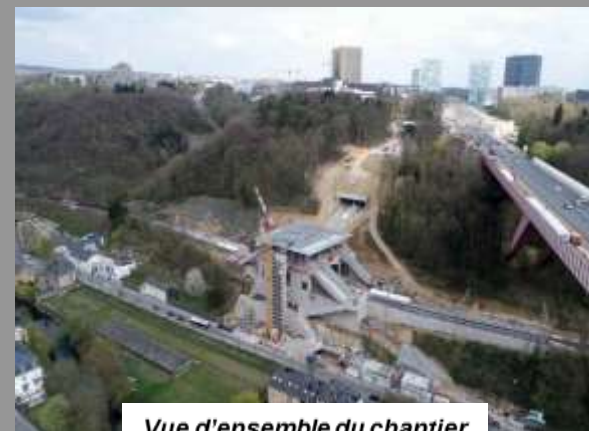
Vue d'ensemble du chantier
