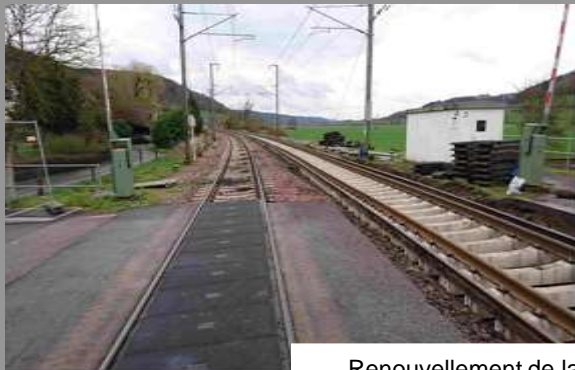
Renouvellement de la voie gauche avec amélioration de la plate-forme entre Lorentzweiler et Mersch
