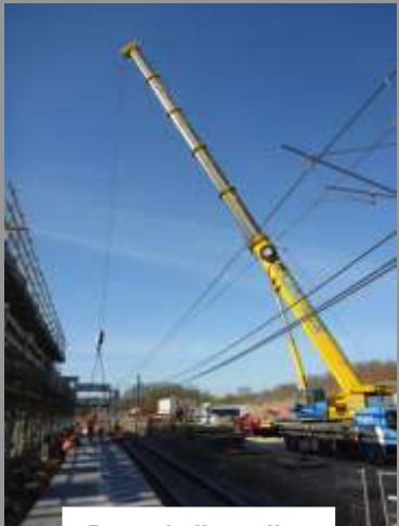
Pose de l'escalier
