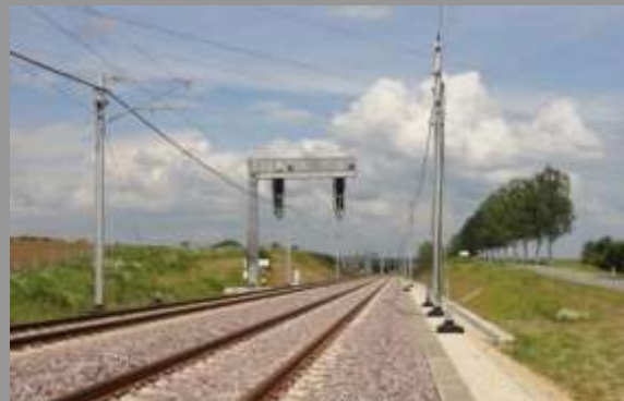
PK 14,800 entre Leudelange et Luxembourg Mise à double voie
