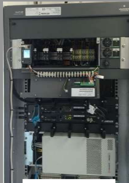
Armoire BTS GSM-R
