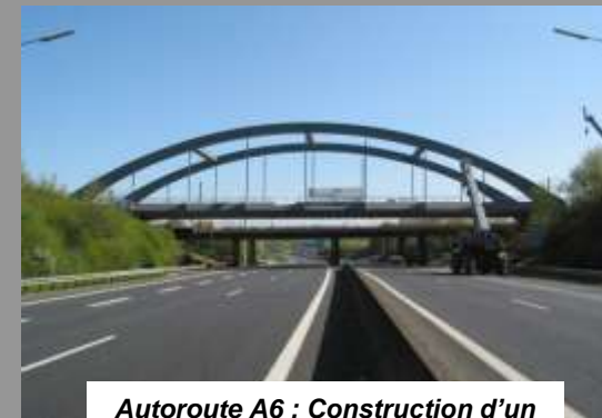
Autoroute A6 : Construction d'un nouvel ouvrage type Bowstring
