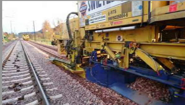
Renouvellement de la voie gauche avec amélioration de la plate-forme entre Lorentzweiler et Mersch
