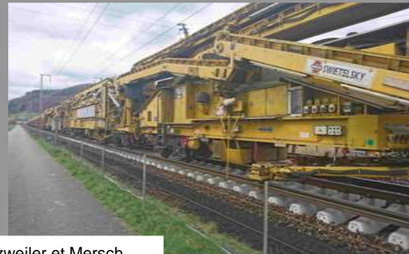
Renouvellement de la voie gauche avec amélioration de la plate-forme entre Lorentzweiler et Mersch
