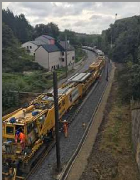
Renouvellement complet des voies avec amélioration des plate-formes entre Colmar-Berg et Schieren
