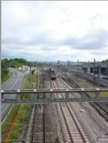
Mise en service de la voie 622
