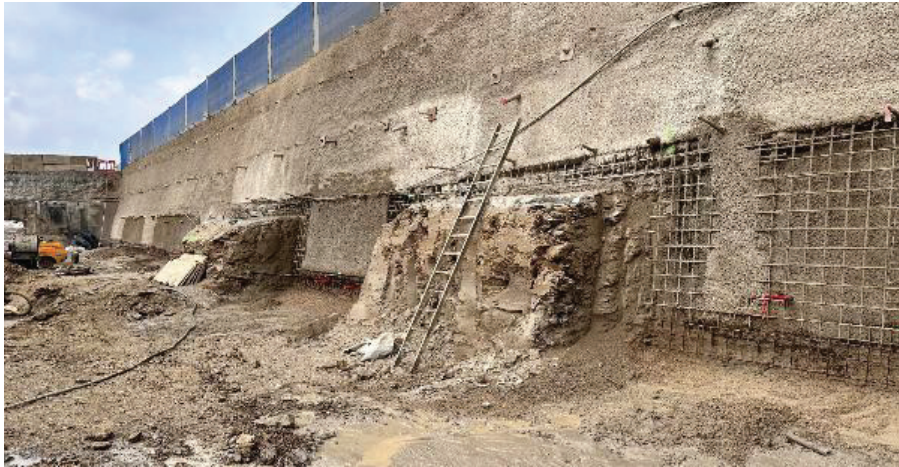
Photo 2 : Phase 1 – Terrassement pour la bretelle d'accès en direction de Luxembourg (juin 2024)
