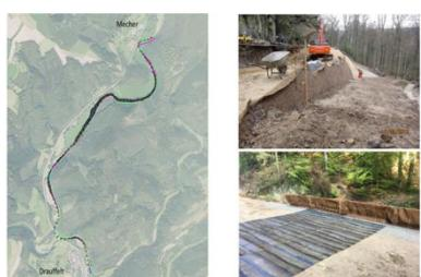
Ces affaissements sont dus, d'après des études géotechniques du sol, à un soubassement en mouvement. En reconstruisant les zones touchées avec de la terre armée depuis le fond stable et en réaménageant la route sur quelques kilomètres, ces mouvements pourront être stabilisés.
