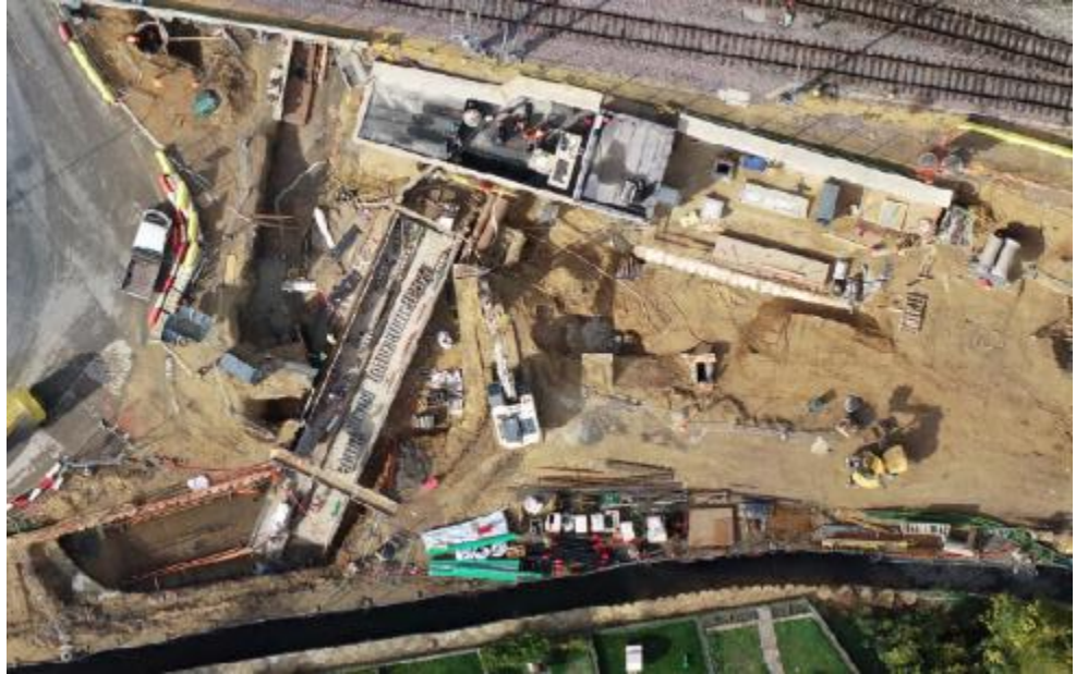
Figure 9 : Photo aérienne de la situation dans le Rangwee en automne 2022 : Coactivité de deux entrepreneurs travaillant pour deux maîtres d'ouvrages différents. Construction du nouvel ouvrage de la Drosbach, avec l'ancien ouvrage toujours en fonction mais relié
