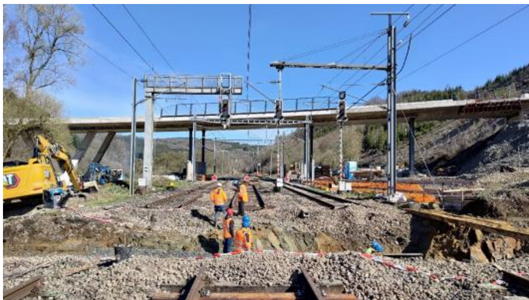
Image 12 Pose du rejet sous les voies de chemin de fer
