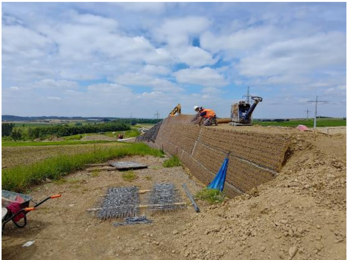
Image 18 Vue sur la stabilisation des rampes
