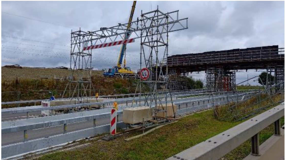
Image 17 Vue sur l'ouvrage avec l'échafaudage en place
