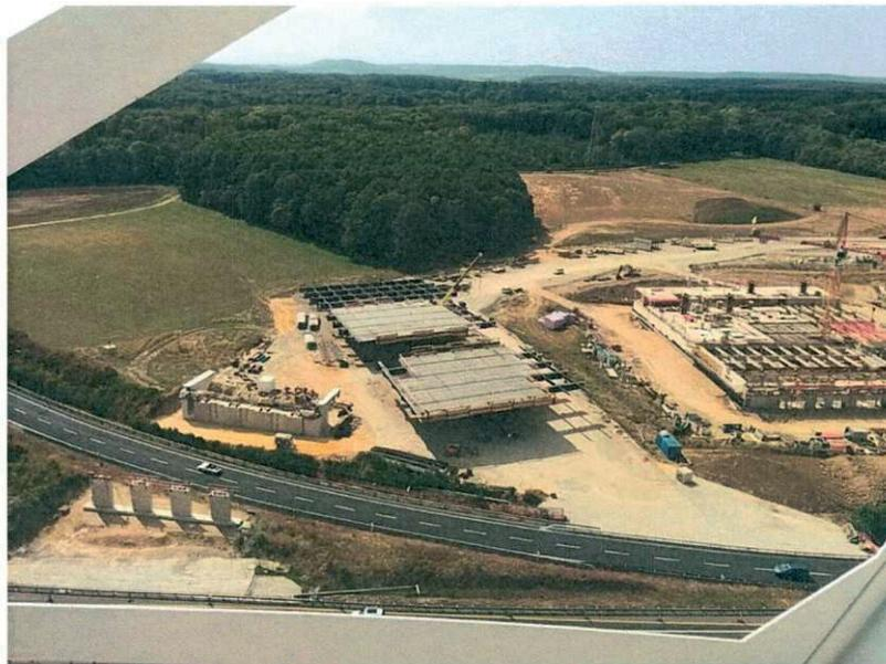
*Figure 27 Ouvrage d'art OA17 – Kamag en place avant le montage du premier tronçon de l'ouvrage*
