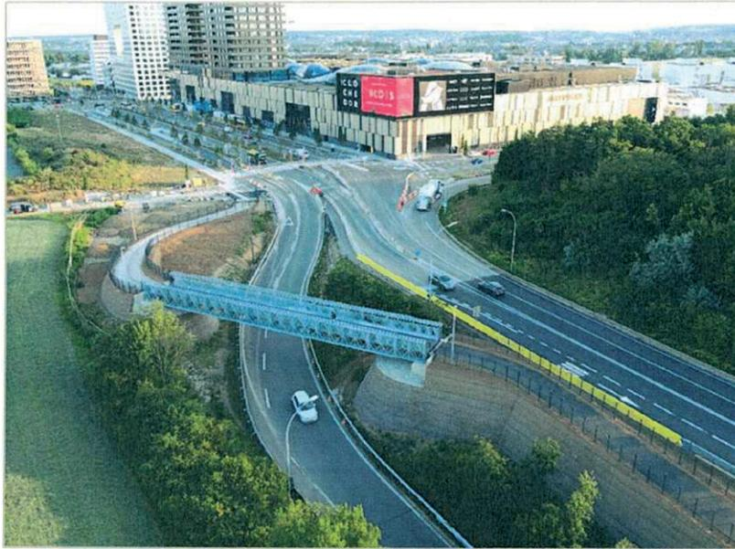
*Figure 39 Elargissement des trottoirs sur les ouvrages existants et sécurisation de la piste par rapport à la voirie*
