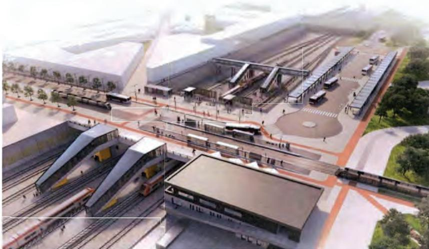
Le quai II, se trouvant entre les voies 153 et 154, aura une géométrie variable. La longueur du quai sera de 307 mètres, à ses extrémités sud et nord le quai aura des largeurs minimales respectives de 4,80 mètres et de 4,20 mètres et sa hauteur sera de 54 cm au-dessus du plan de roulement.
