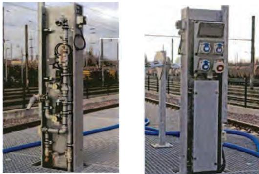
Figure 3: Bornes de préchauffage
