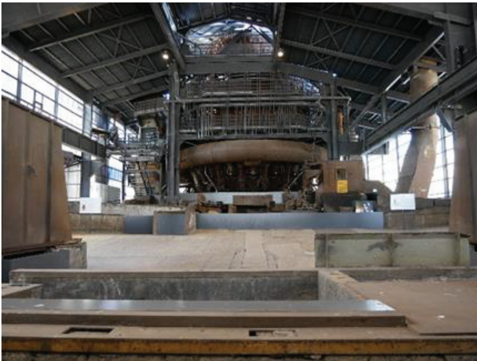
Plancher des Coulées, vue intérieure
