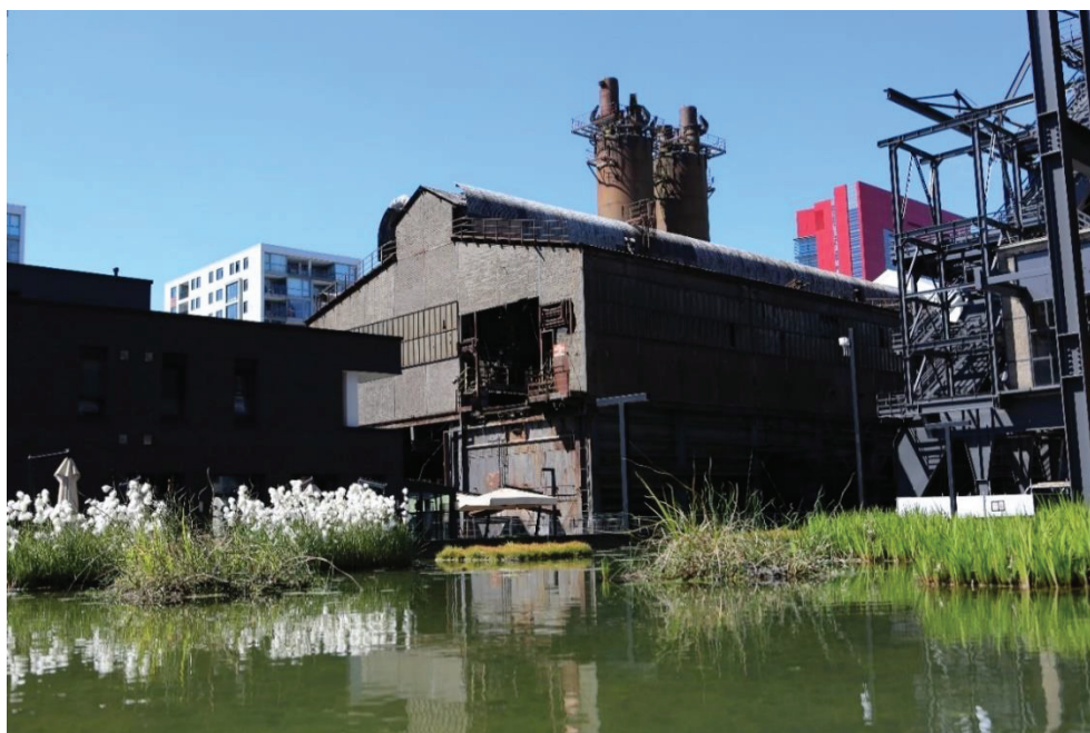
Möllerei, vue sud-est
