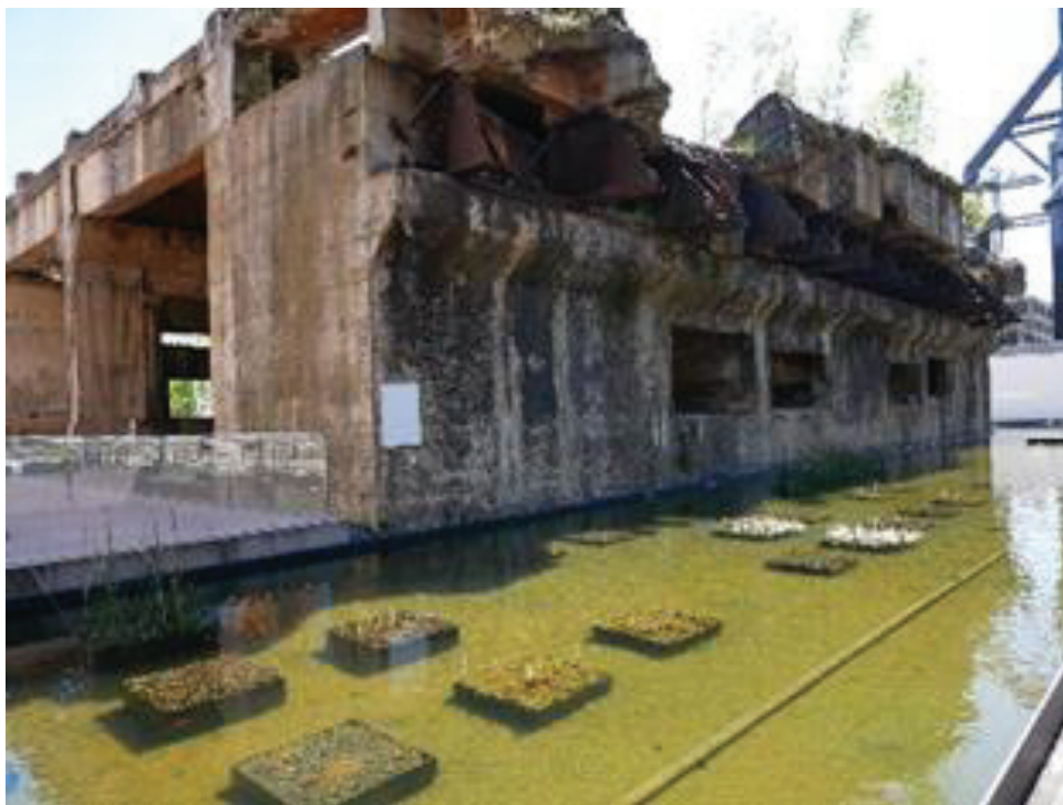
Fondation du Haut fourneau C, vue nord-ouest
