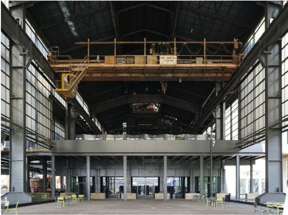
Espace urbain, vue depuis la Halle couverte
