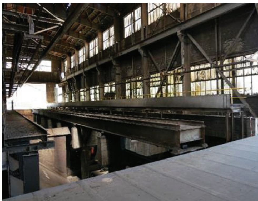
Möllerei, vue intérieure
