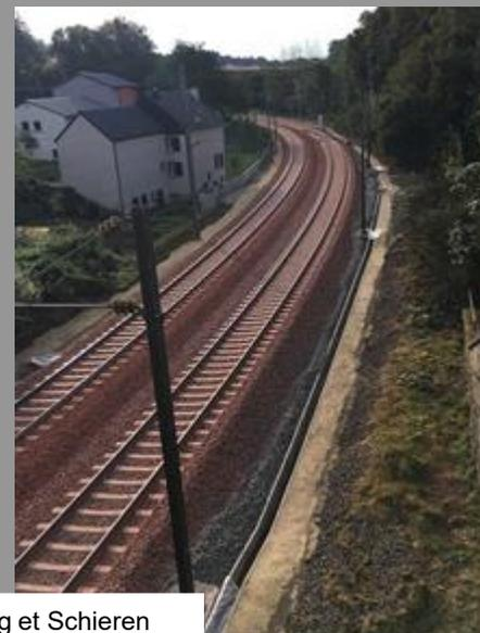
Renouvellement complet des voies avec amélioration des plate-formes entre Colmar-Berg et Schieren
