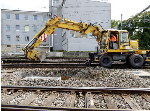
Travaux génie civil
