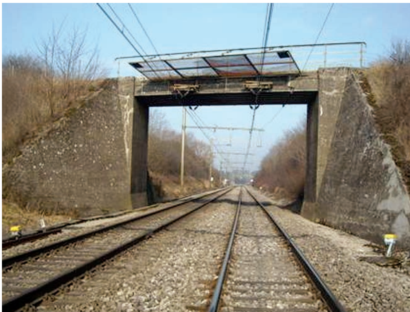
ouvrage d'art situé au point kilométrique 8,913 à Mamer-Lycée
