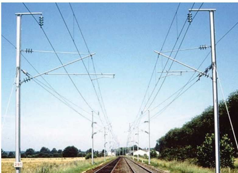
Caténaire 2 AC 25 kV 50 Hz (projet)
