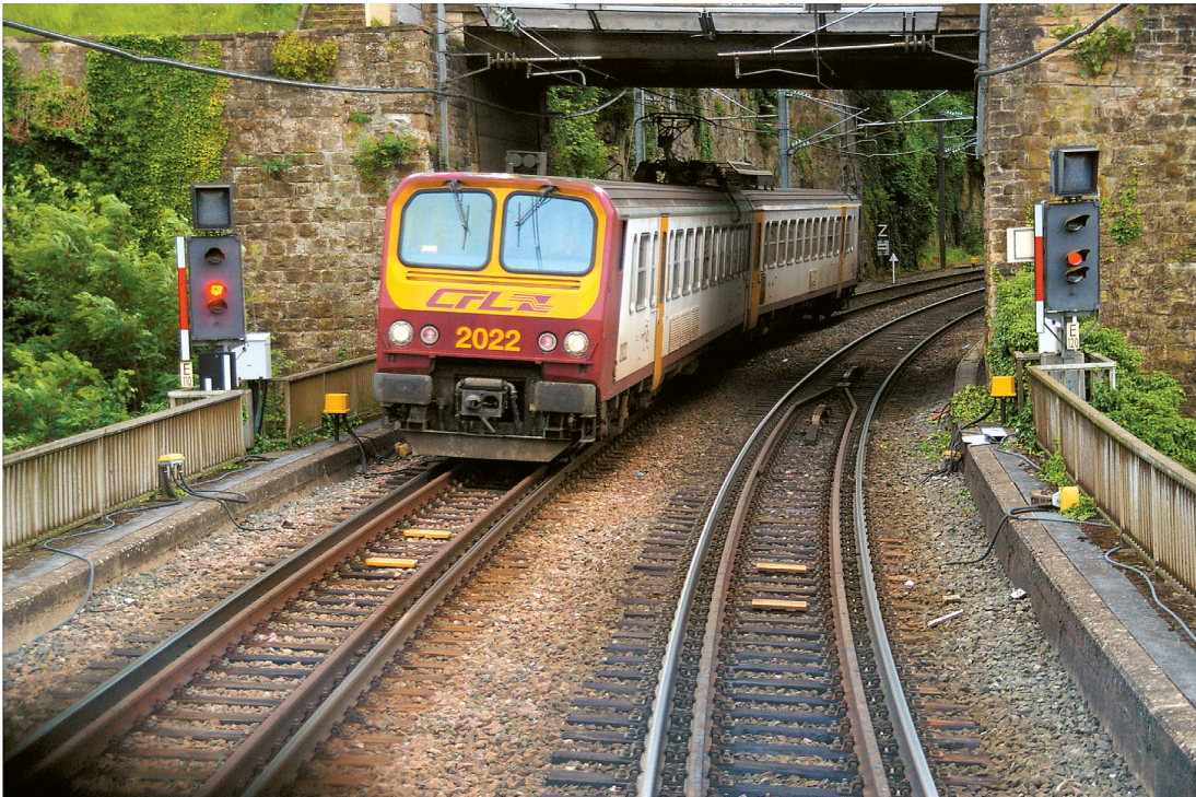
Le système ERTMS/ETCS en service (balises installées et signaux équipés avec LEU).
