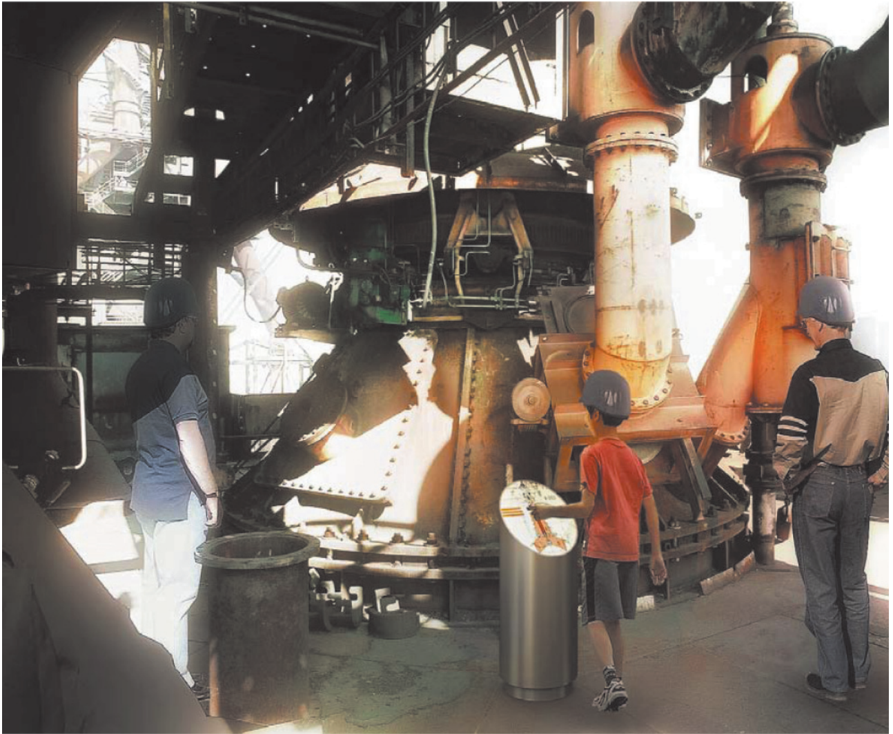
STATION DE VISITE SUR LE PLANCHER GUEULARD
