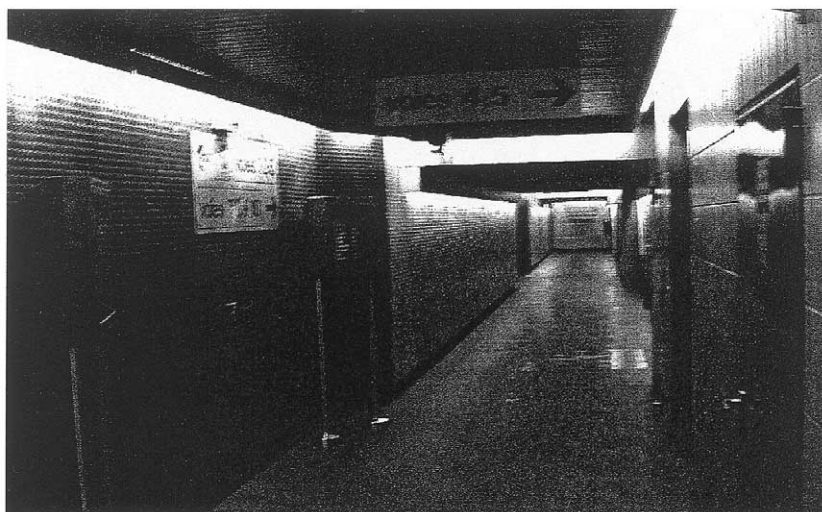
Situation existante du souterrain sud
