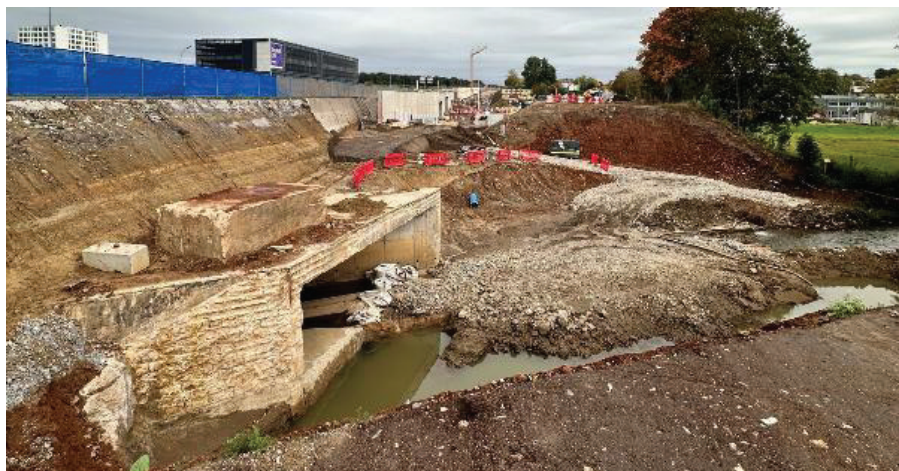
Photo 3 : Phase 1 – Terrassement pour la reconstruction d'une partie de l'ouvrage sur la Mess (oct. 2024)
