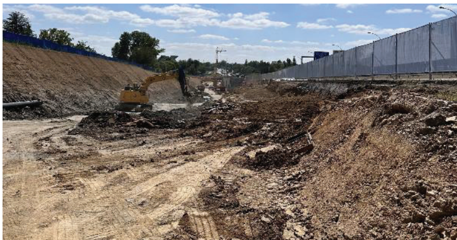
Photo 3 : Phase 1 – Terrassement pour la reconstruction d'une partie de l'ouvrage sur la Mess (oct. 2024)
