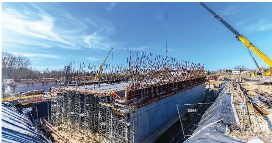
Photo 5 : Construction de l'ouvrage d'art 02 de l'OA 1106 (février 2019)
