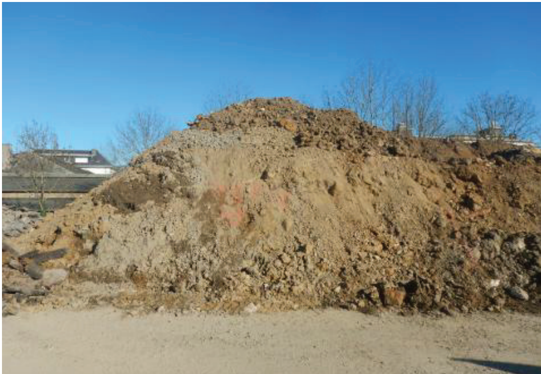
Figure 2 : Tas de matériaux de déblais entrestockés à des fins d'analyses chimiques
