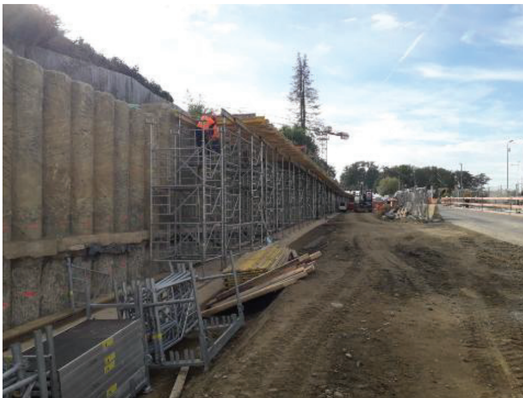
Figure 10 : construction de la poutre de couronnement sur le mur de soutènement de la rue des Scillas
