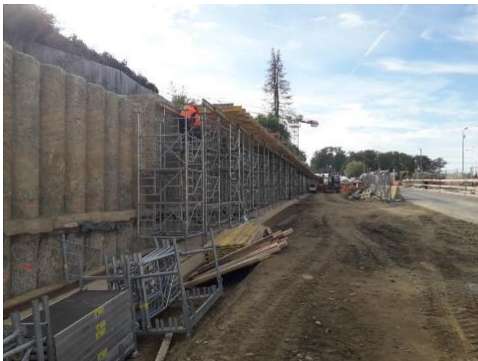
Figure 10 : construction de la poutre de couronnement sur le mur de soutènement de la rue des Scillas
