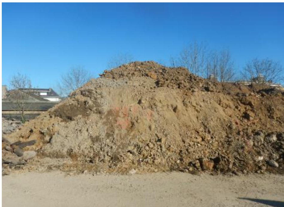
Figure 2 : Tas de matériaux de déblais entrestockés à des fins d'analyses chimiques
