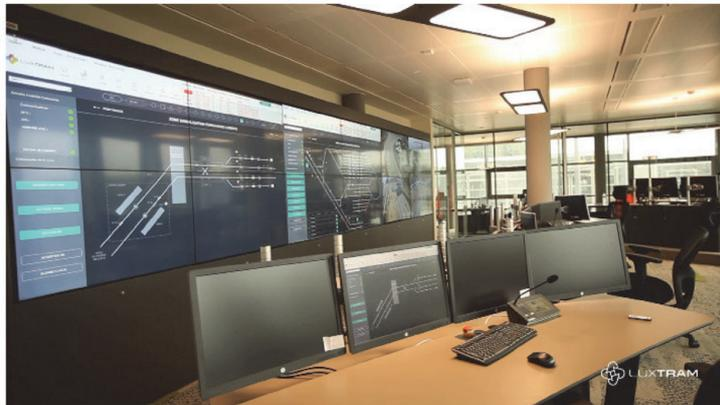
Le PCC gère la régularité de la fréquence du tramway. En cas de perturbation, il est en interface avec l'ensemble des conducteurs pour limiter les retards et désagréments.
